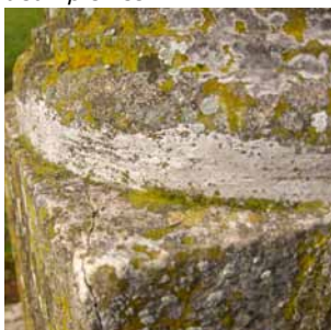
Joint au mastic entre deux pierres
