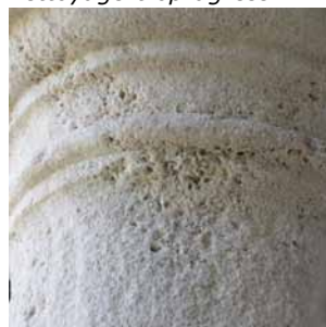
Pierre émoussée par un nettoyage trop agressif
