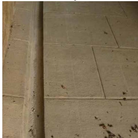
Reprise de la goulotte et du dallage en cohérence avec l'ouvrage
