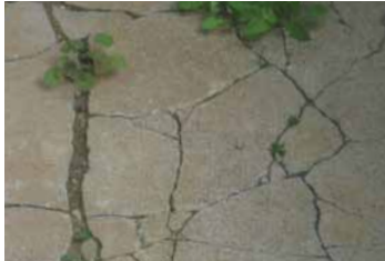
Problèmes d'étanchéité au fond du bassin ou entre les pierres de lavage
