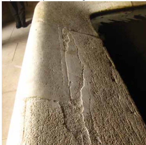
Reprise d'une pierre de lavage avec soin
